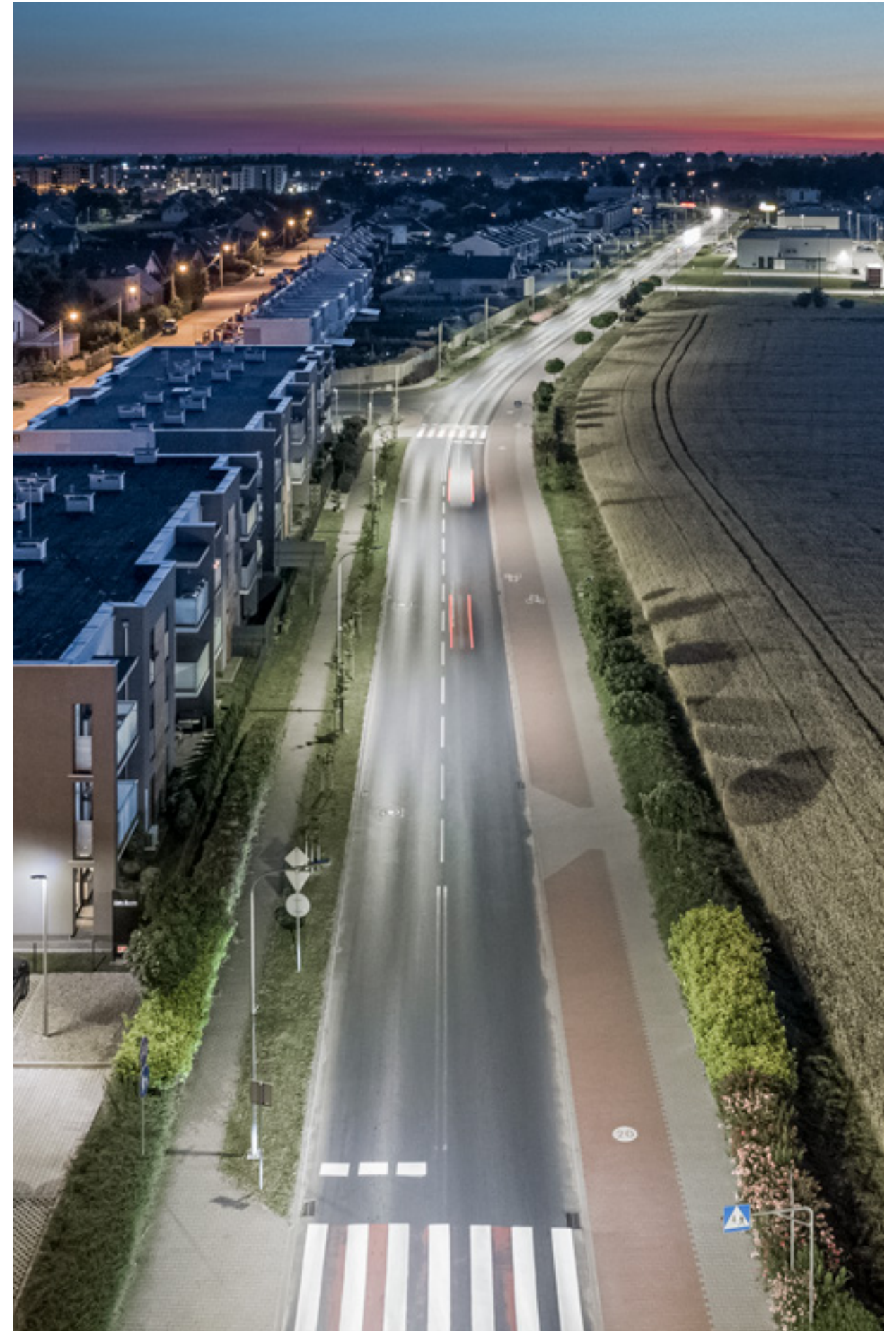
Road lighting in Środa Wielkopolska
